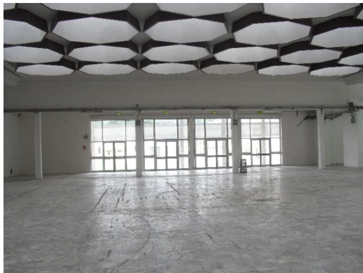
soffitto con travi in ca e solette SAP soffitto cassettonato con lucernari padiglione 1 - sala F
