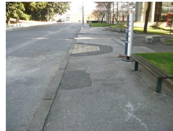
percorsi pedonali e carrabili in tappetino bituminoso, cordoli in pietraresa e rampe per disabili
