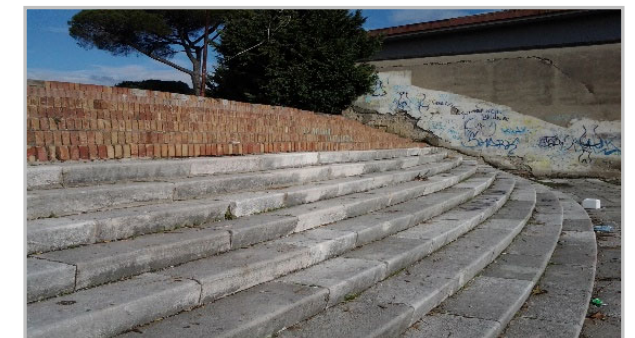
gradoni in pietra e mattoni pieni scala Antiniana ingresso nord
