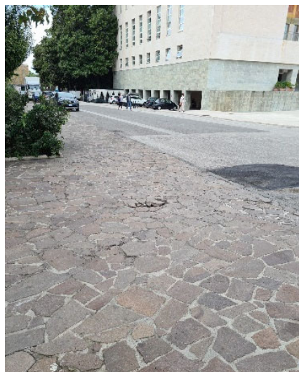
pavimentazione in bollettonato di porfido aree esterne ai padiglioni fieristici
