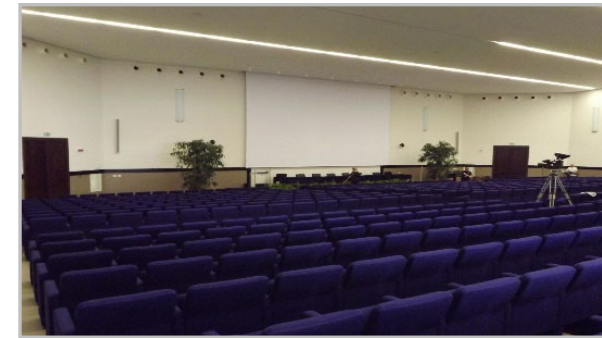
Pavimentazione in linoleum, lambrini in materiale fonoassorbente sala Europa
