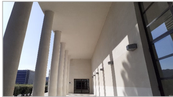
tinteggiatura ai silicati, infissi in ferro e pavimentazione in lastre di travertino porticato di ingresso
