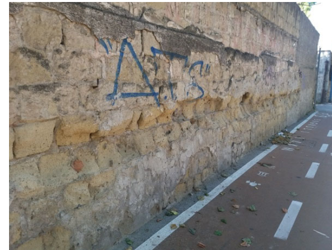
chiusure perimetrali in muratura di tufo
