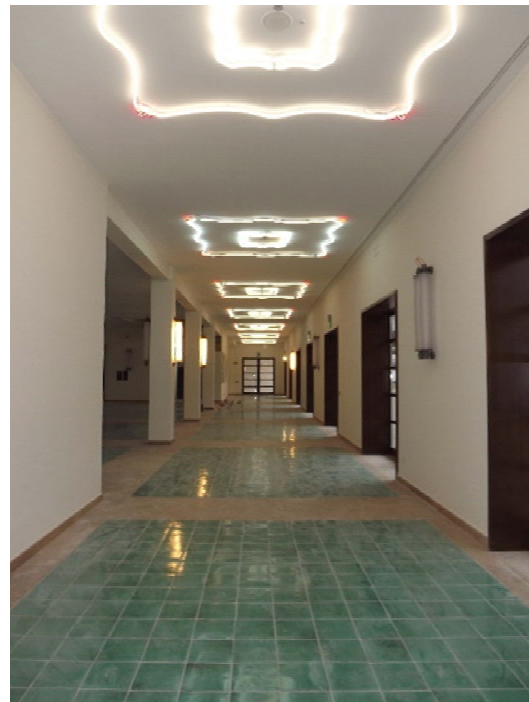
pavimento in maiolica e fasce in travertino sala bar/ristorante - piano terra
