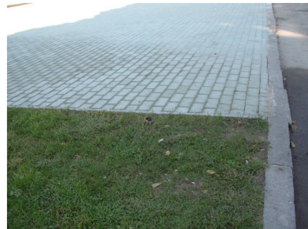
delimitazione pavimentazione in betonelle con cordoli in pietrarsa
