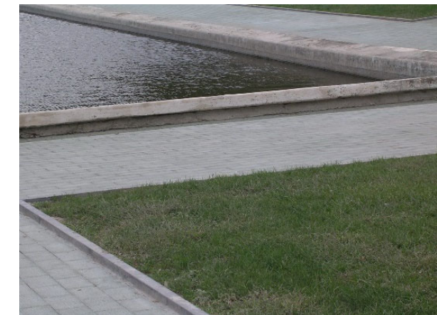
bordatura sagomata delle vasche in c.a. rifinita ad intonaco
