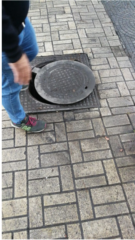
pavimentazione in betonelle di cemento aree esterne padiglione 5 - 6
