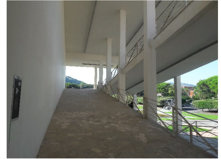
pavimentazione in bollettonato di travertino e ringhiere in ferro ed acciaio rampa esterna di collegamento
