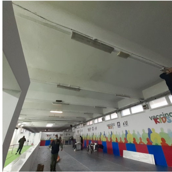
soffitto con travi in ca e solette SAP padiglione 1 - sala D
