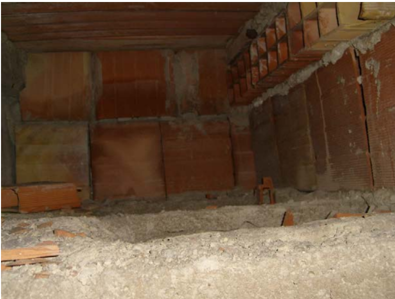
FOTO SOLAIO PADIGLIONE 9
