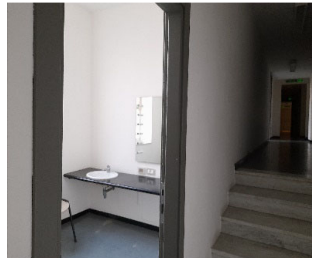
pavimenti in linoleum camerini del teatro
