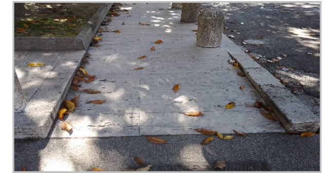
marciapiede con pavimentazione e cordoli in travertino
