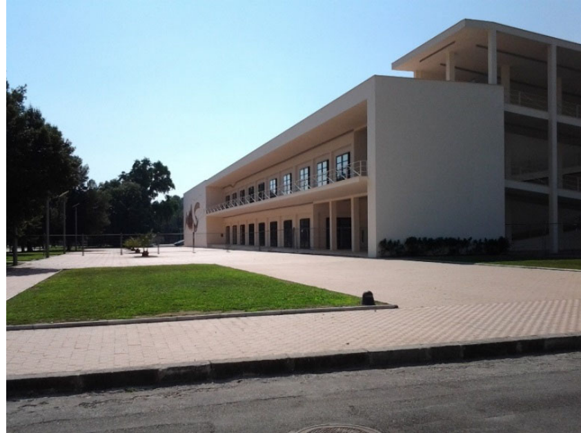
pavimentazione in betonelle di cemento ristorante della piscina
