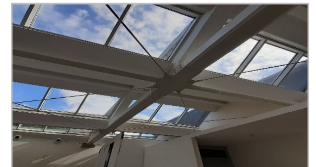
copertura in capriate in c.a. e controventature in acciaio soppalco - atrio centrale
