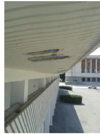
pensilina in c.a. porticato padiglioni 1-2-3
