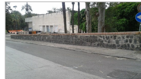
pavimentazione stradale aree esterne padiglione Libia
