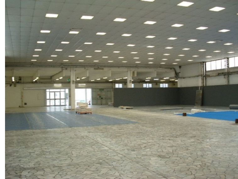
copertura con capriate in ferro e controsoffitto in pannelli padiglione 1 - sala A
