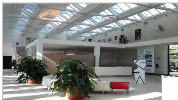
capriate in c.a. e lucernari con profili in alluminio atrio principale
