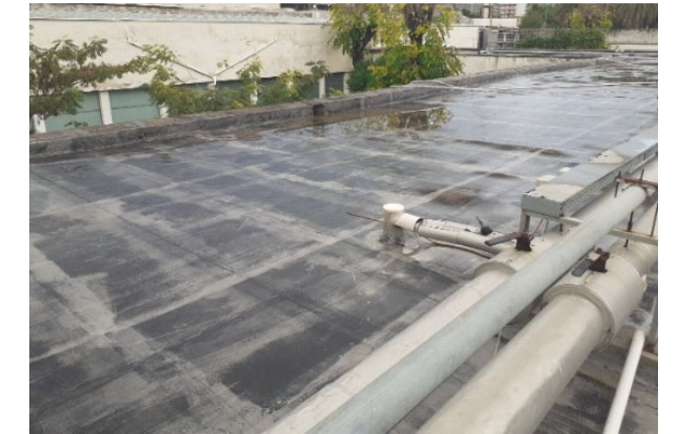
copertura sala D del padiglione 1
