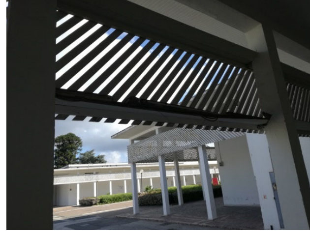
elementi frangisole in legno porticato padiglioni espositivi 1-2-3
