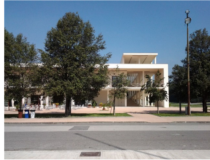
prospetto sud lato rampa di collegamento
