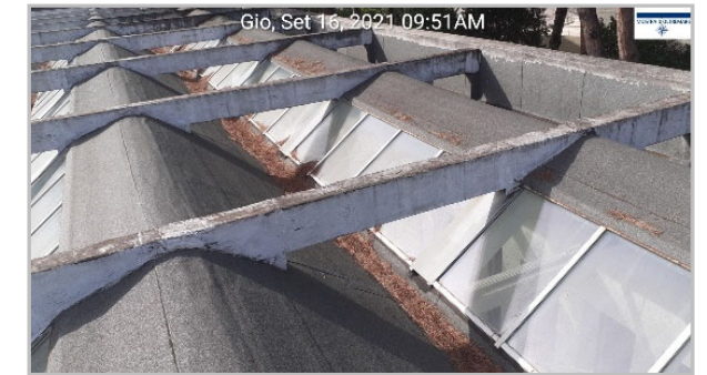
manto impermeabile in teli di guaina ardesiata copertura atrio centrale
