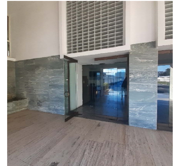
porte in cristallo sistema di chiusura con mab a pavimento
