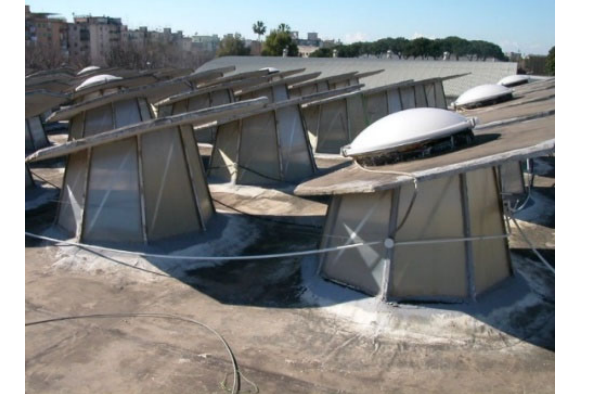
copertura sala F del padiglione 1
