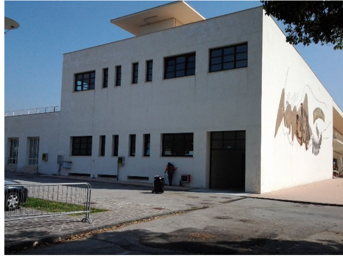
murature esterne con pitture a calce ed infissi in legno - prospetto ovest
