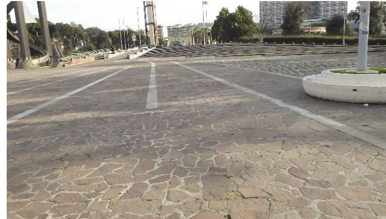
pavimentazione in bollettonato di porfido ingresso piazzale V. Tecchio
