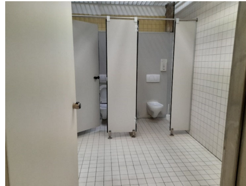
divisori wc e docce in pannelli in melaminico laminati
