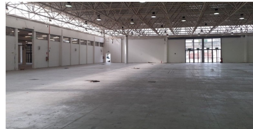
struttura reticolare in acciaio padiglione 3b
