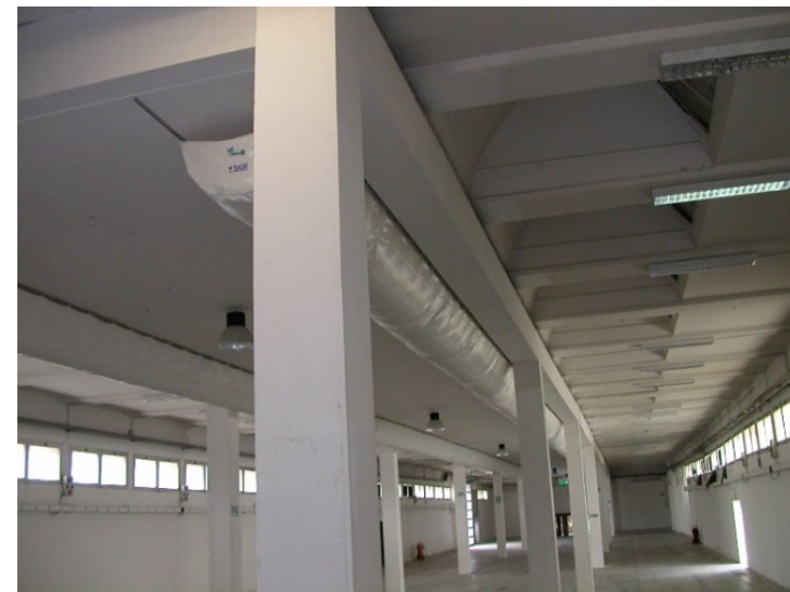
soffitto con travi estradossate, solette SAP e cupolini padiglione 3 - sala B
