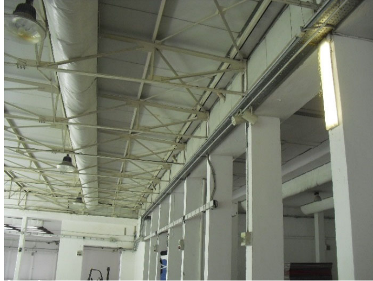
copertura con capriate in ferro padiglione 1 - sala B
