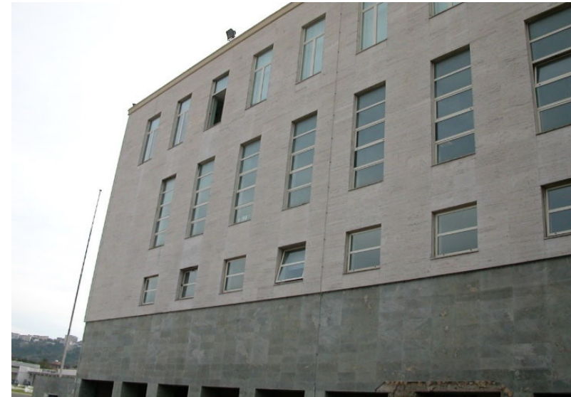
Infissi in alluminio preverniciato– prospetto nord
