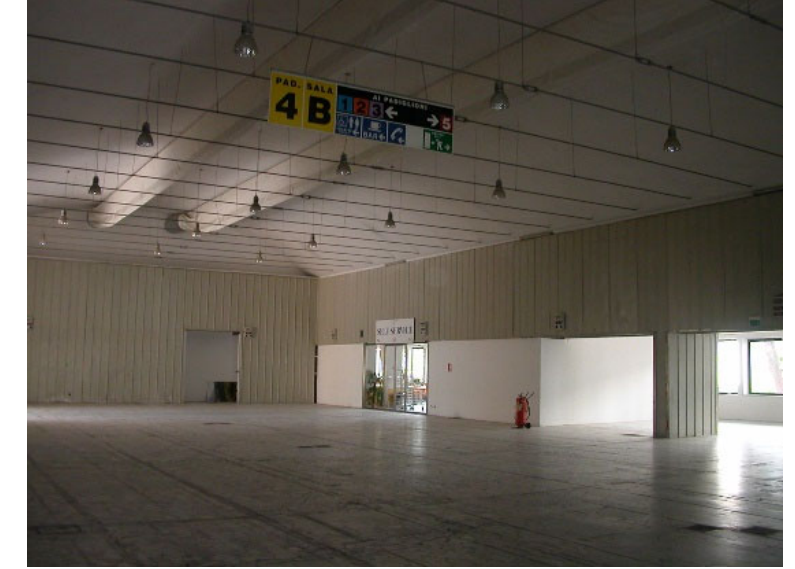
copertura a volta in c.a. padiglione 4 - sala B
