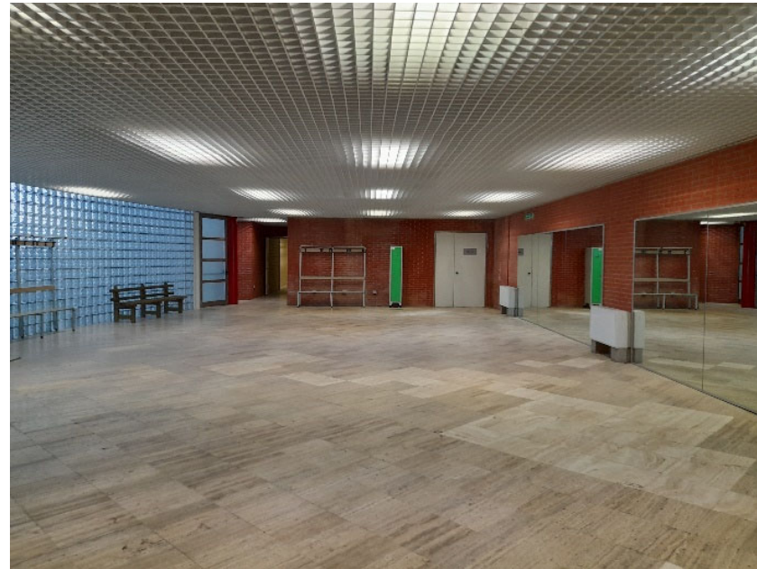
pavimentazione in travertino e controsoffitto ispezionabile spazi comuni – livello piscina coperta
