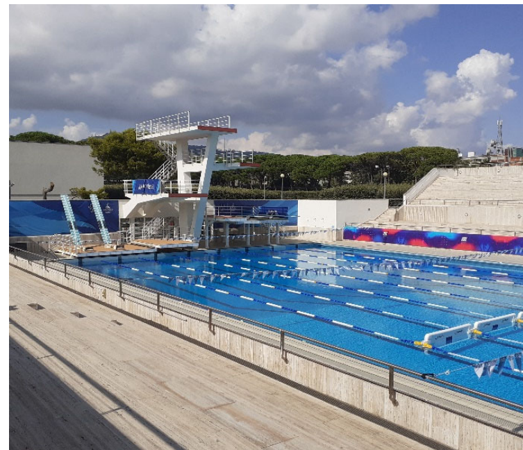
rivestimento in lastre di travertino e balaustre in acciaio inox spalti della piscina olimpionica
