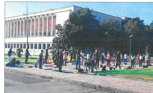
IL PIAZZALE PAVIMENTATO ANTISTANTE
