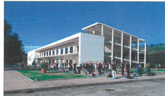
IL PIAZZALE PAVIMENTATO ANTISTANTE
