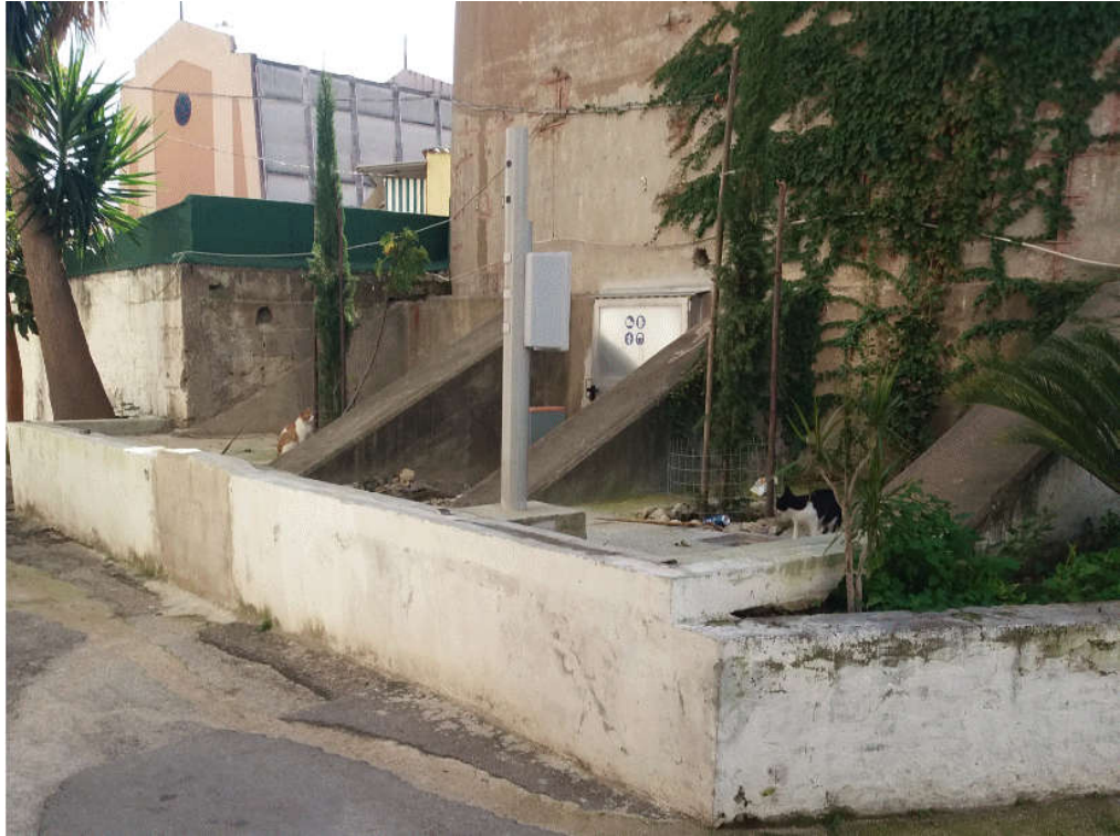
Fig.13 – Pilone 3 – Parte bassa - Lato Nord-Est
