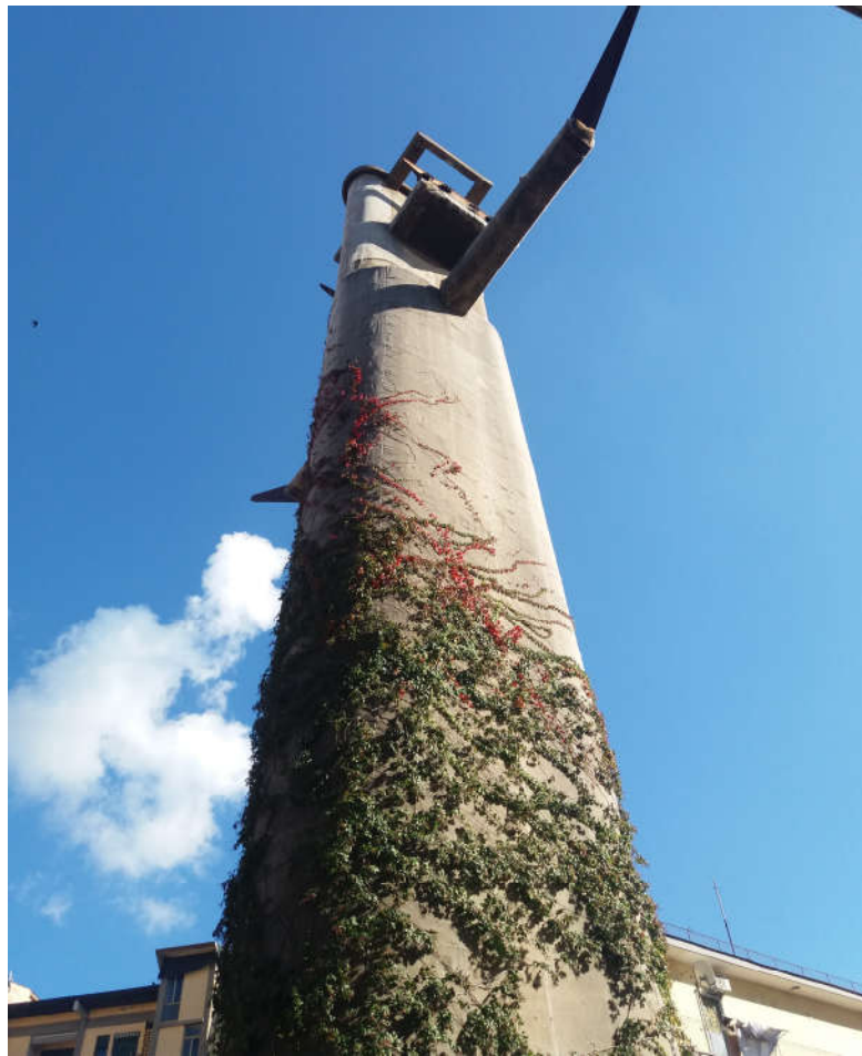
Fig.9 – Pilone 2 –Lato Sud-Est
