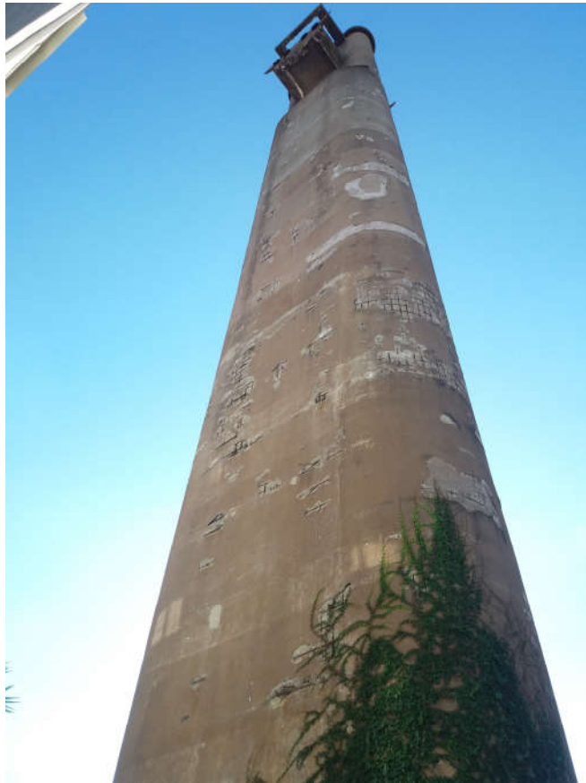
Fig.11 – Pilone 3 – Lato Nord-Est
