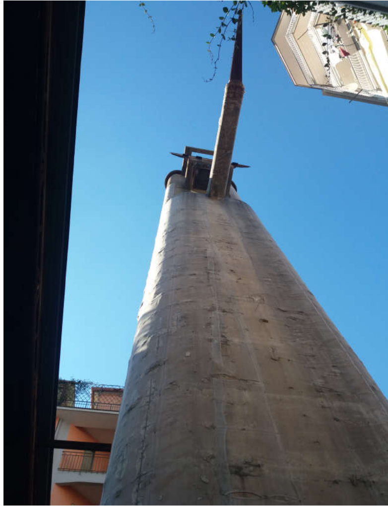
Fig.6 – Pilone 1 – Lato Sud-Est
