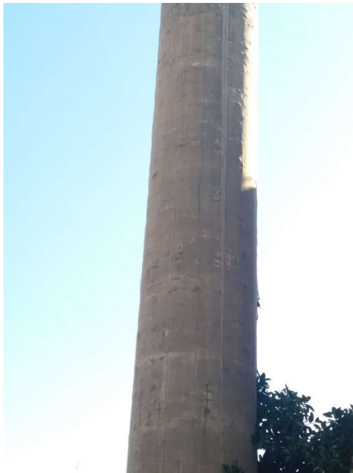
Fig.3 - Pilone 1 – Parte intermedia - Lato Nord
