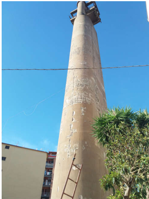
Fig.12 – Pilone 3 – Lato Sud-Est
