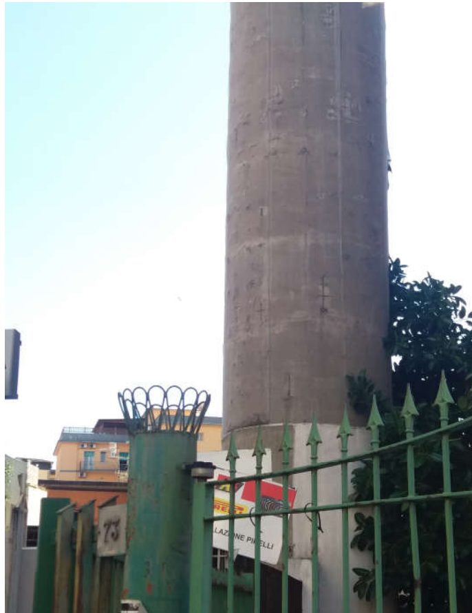
Fig.4 - Pilone 1– Parte bassa -Lato Nord
