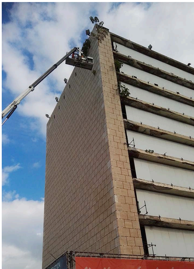
foto 6 – intervento in sommità della torre, con l'ausilio di piattaforma con cestello
