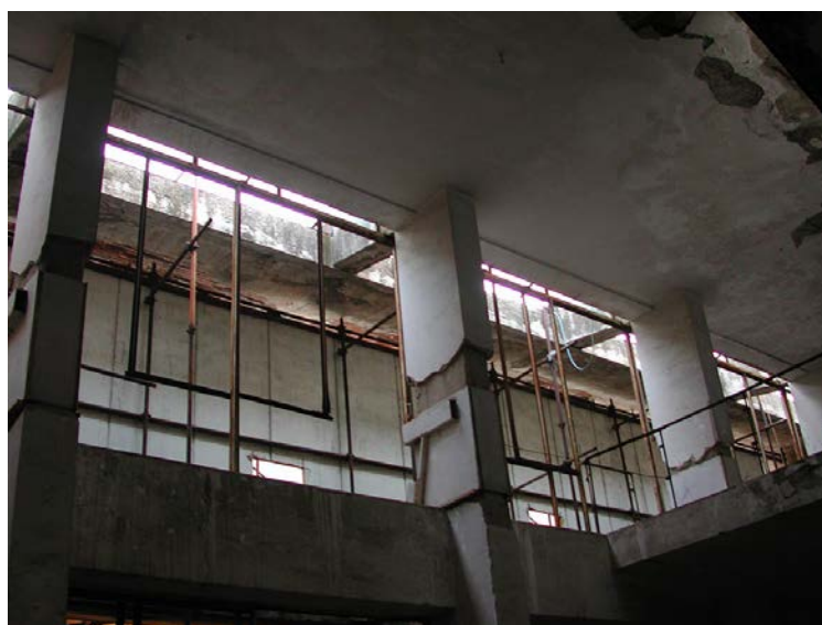
foto 5 – vista dall'interno dell'edificio dei profili in ferro degli infissi originari e lamiera ondulata esterna di protezione
