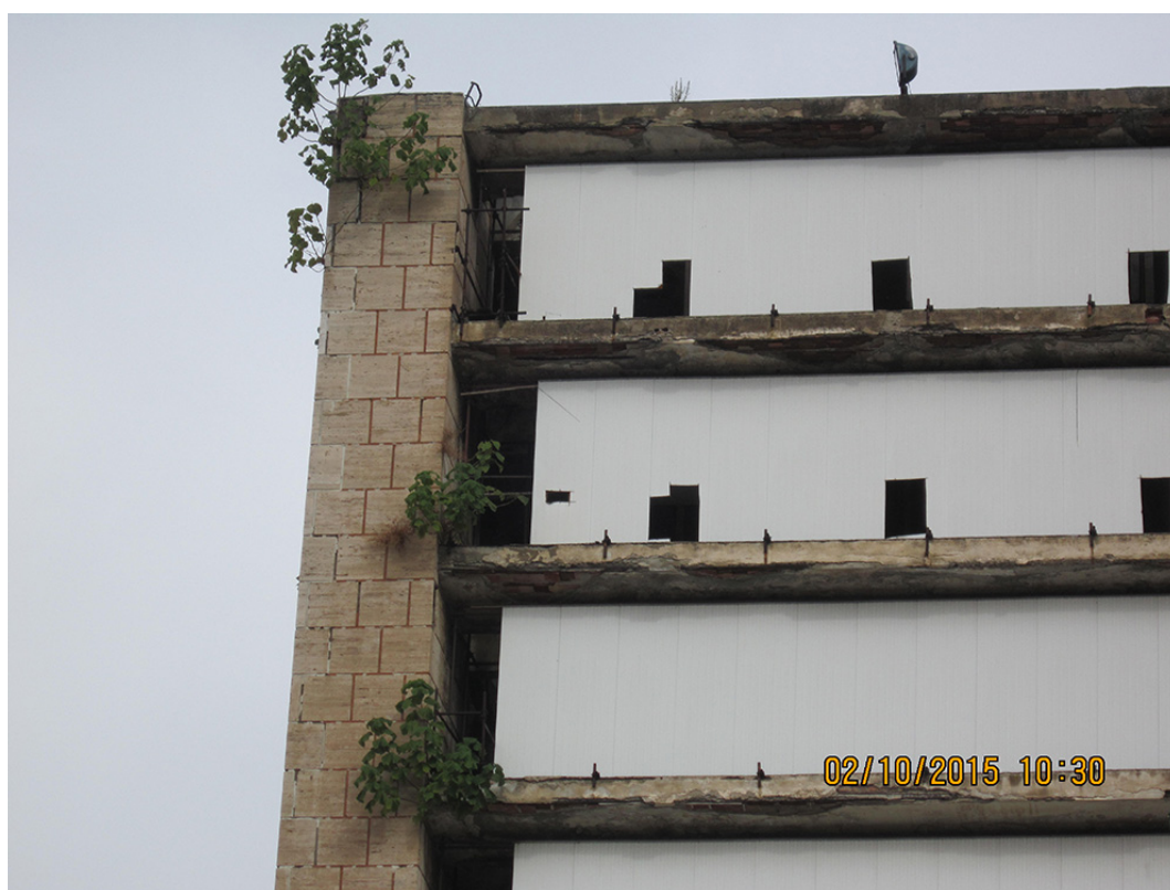
foto 3 – elementi in cemento armato a sbalzo del prospetto sud
