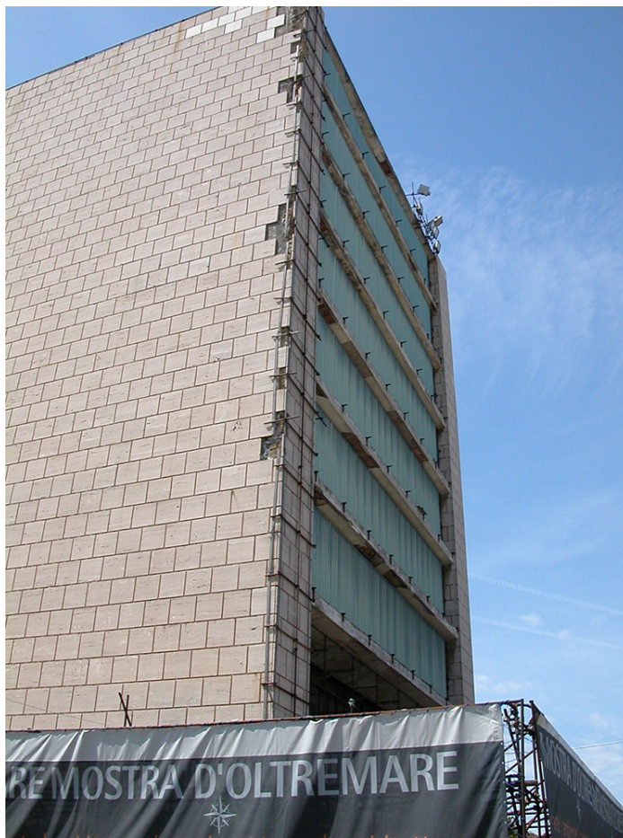
foto 2 – il prospetto sud ed est della Torre delle Nazioni
