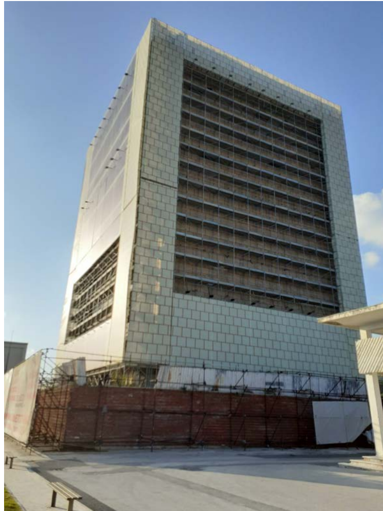
foto 7 – il ponteggio realizzato
