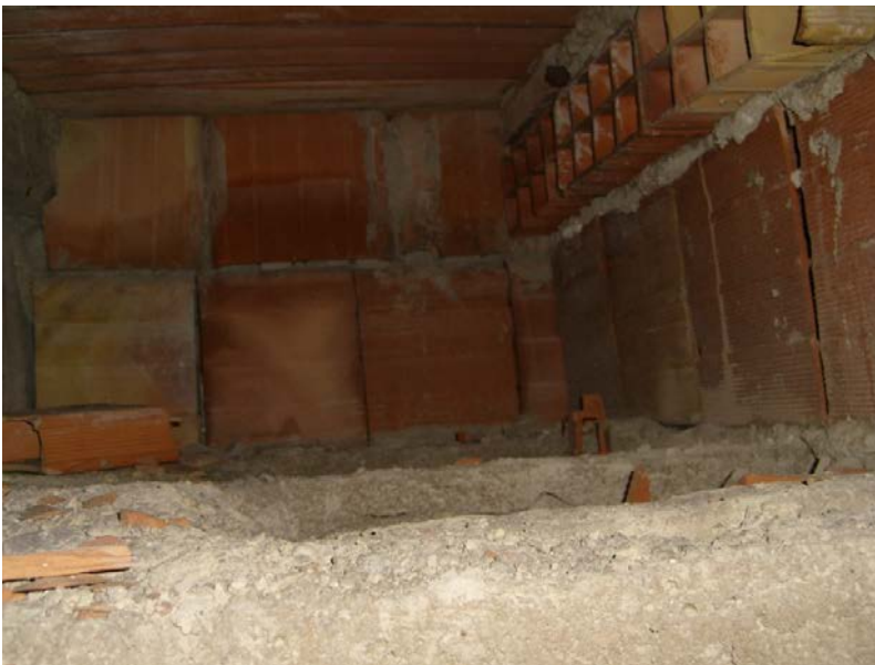
FOTO SOLAIO PADIGLIONE 9
